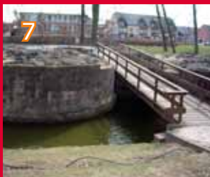
7 Toegangspartij, geflankeerd door 2 torens.
