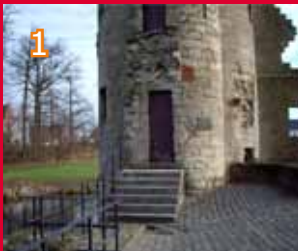
1 Woontoren met aangebouwde traptoren.
